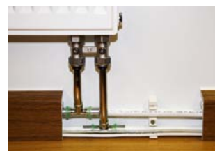
Napojení radiátoru
